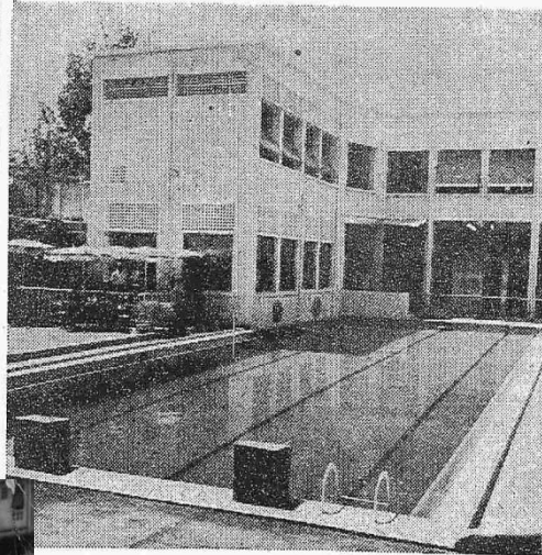
nouvelle piscine des T.A. a été inaugurée samedi et, dans un cadre charmant, va accueillir de nombreux nageurs
