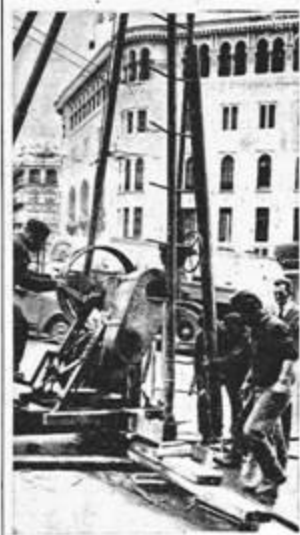
La rue Monge sera toujours fermée à la circulation automobile jusqu'à l'achèvement des travaux de réfection de la ligne de tramway à voie étroite. Les travaux de réfection de la ligne de tramway à voie étroite sont en cours d'exécution. Les travaux de réfection de la ligne de tramway à voie étroite sont en cours d'exécution. Les travaux de réfection de la ligne de tramway à voie étroite sont en cours d'exécution.
